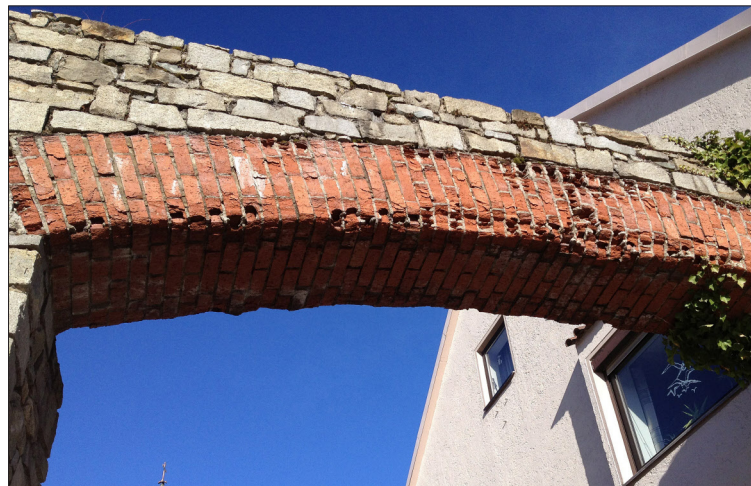
Die Klinkerbögen an der Ringmauer bröckeln – die mittelalterliche Anlage muss saniert werden. – Fotos: Seidl/Skizze: SSP Planung
